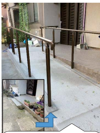
スロープにして段差を無くし、手すりも取り付けました。車いすでも出入りできるようになっています。
