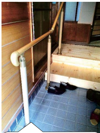
玄関の高さを2段にして低くし手すりもつけて上がり降りをしやすくしました。
