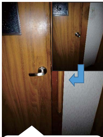
丸いドアノブからレバー式のドアノブに取り替えました。ドアの開け閉めも楽になります。
