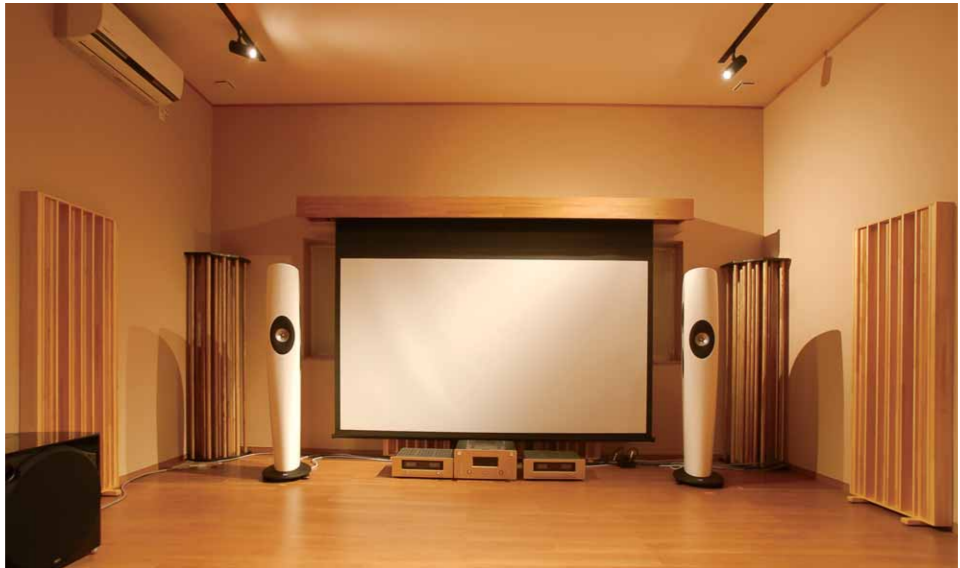
壁300mm厚の断熱材に覆われたリスニングルームは、断熱性能だけでなく、防音効果にも優れ、住宅地でも安心して音楽を楽しむことができます。また、音質を高めるため、床は土間床工法が採用されています。
