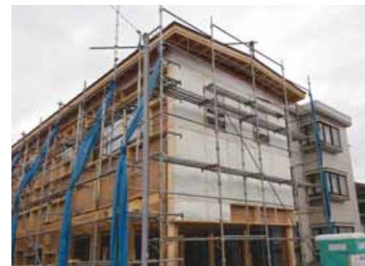
外壁側に200mm厚の付加断熱施工をおこないました。内側の充填断熱を加えると、300mm以上の断熱厚となります。
