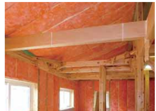
室内側の断熱材を1枚ずつ丁寧に充填しています。見えなくなる部分も丁寧に。
